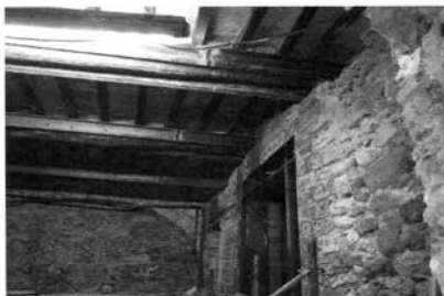
Foto eseguita durante i lavori.
