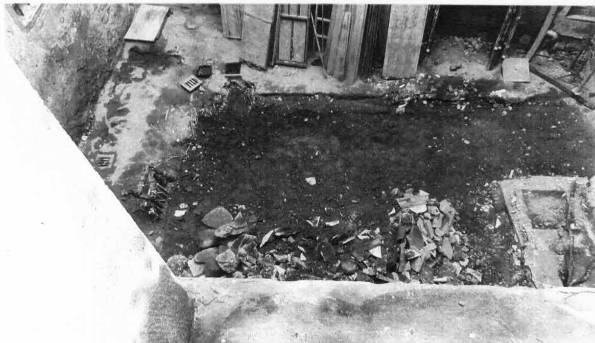
VISTA DELLA CORTE INTERNA O CHIOSTRO, DOPO LA DEMOLIZIONE DELLA STANZA, RIPORTATO ALLO STATO ORIGINARIO PRESCRITTO DALLA RELATIVA SCHEDA TIPOLOGICA (nostro allegato 4bis)
